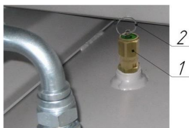
Рисунок 8 – Клапан предохранительный пружинного типа
